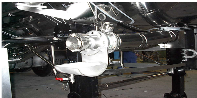
Fotografie výpustního potrubí
