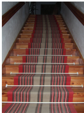
Kluzké schody pokryté kobercem /zabezpečeno/
