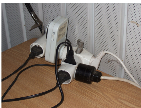
Napojování kabelů v klubovně
