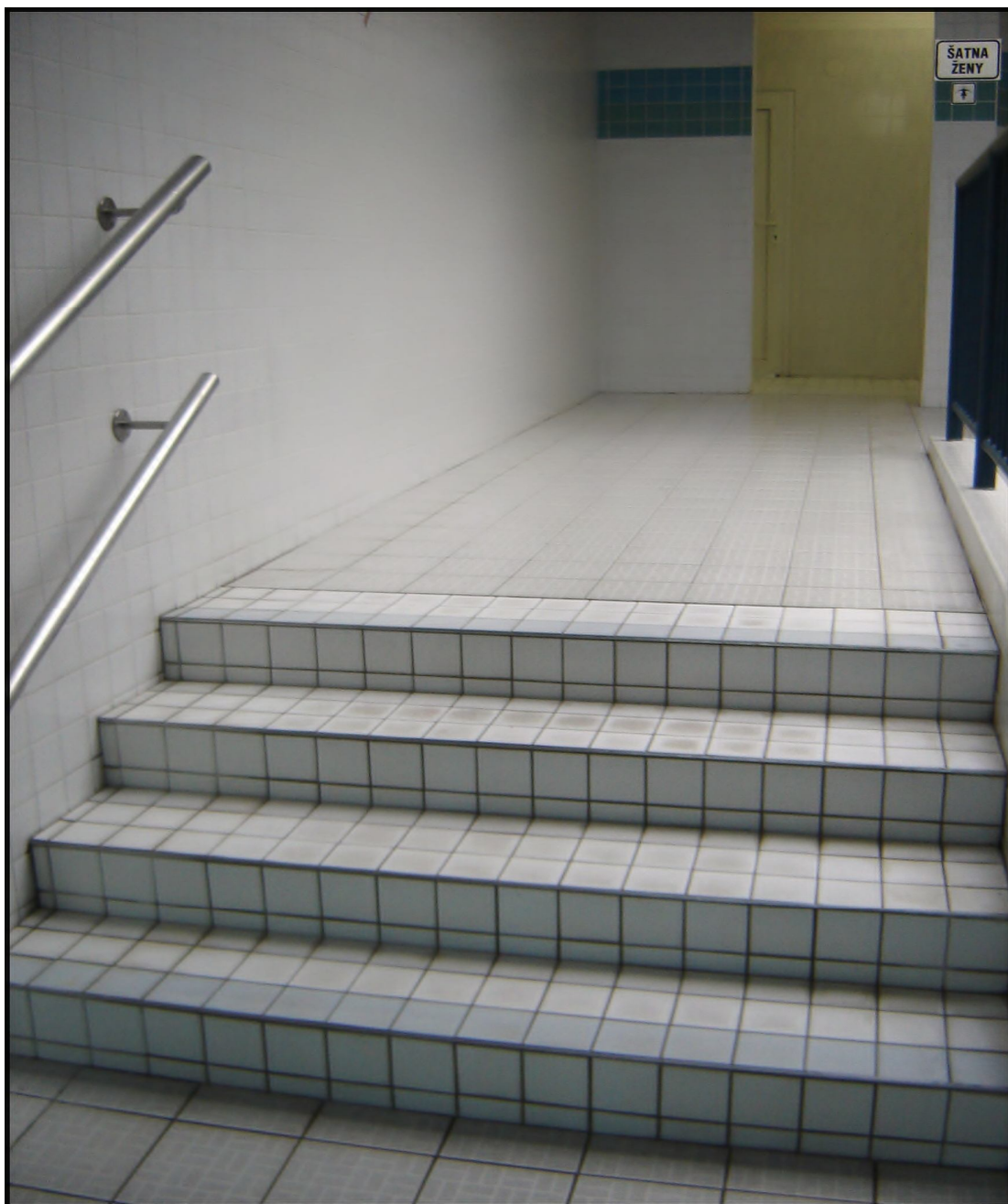
Foto č. 14 Schody do dámských sprch
