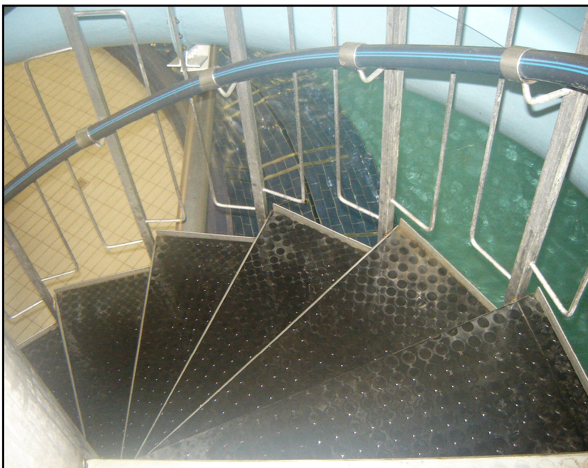
Foto č. 4 Schodiště na skluzavku
