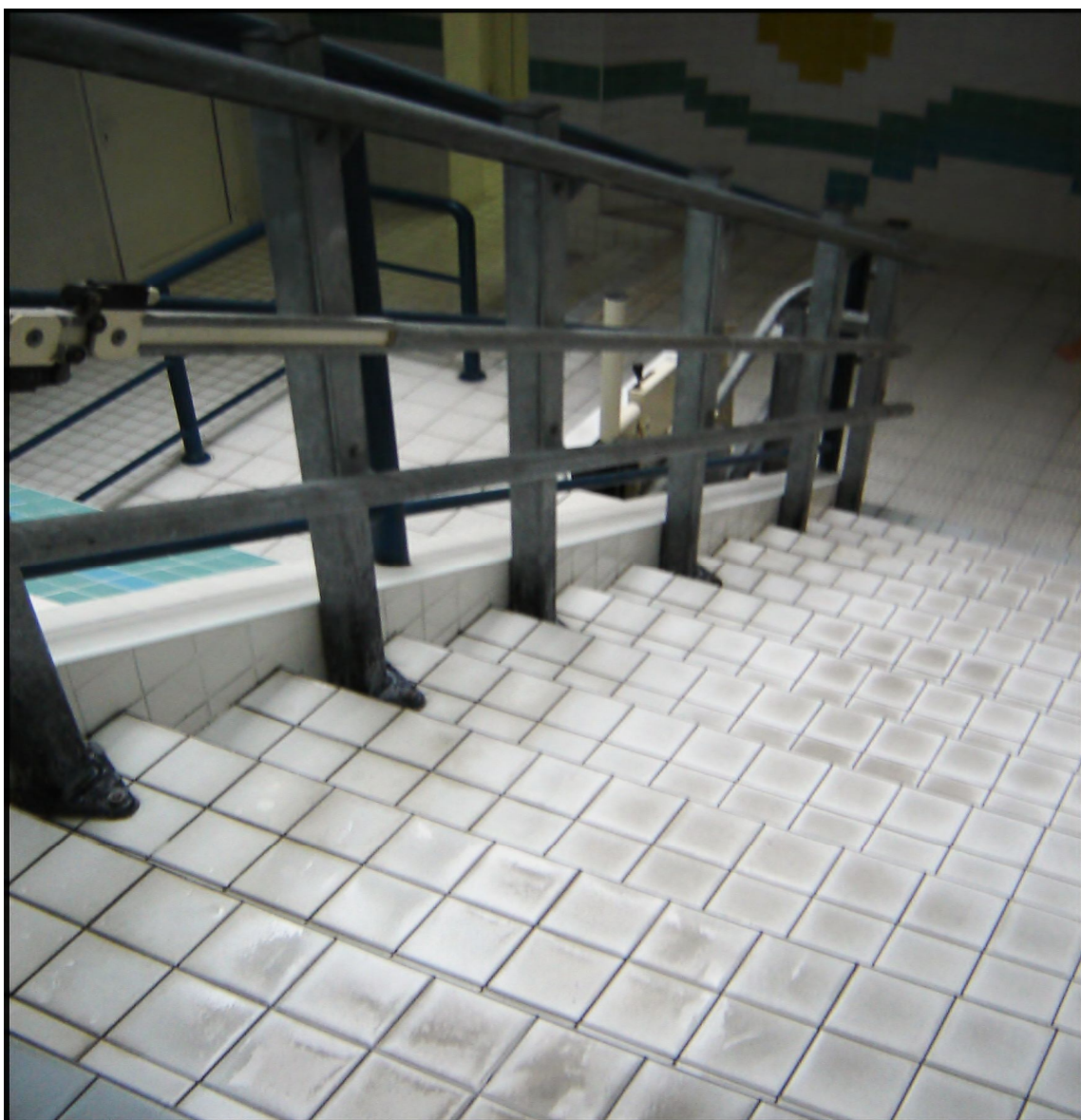
Foto č. 17 Schody do pánských sprch
