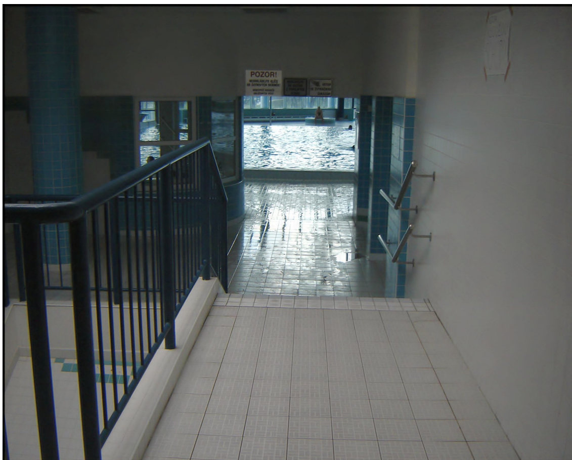
Foto č. 13 Úsek z dámských sprch k bazénu
