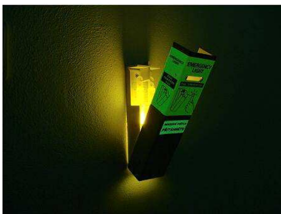
Obrázek č. 1 Chemické světlo nouzového osvětlení
