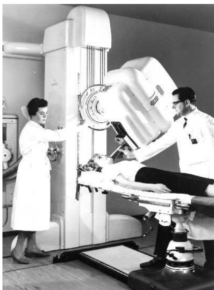
Obr. 62 - 15 MeV betatron z roku 1956 postavený podle návrhů Konrada Gunda.
