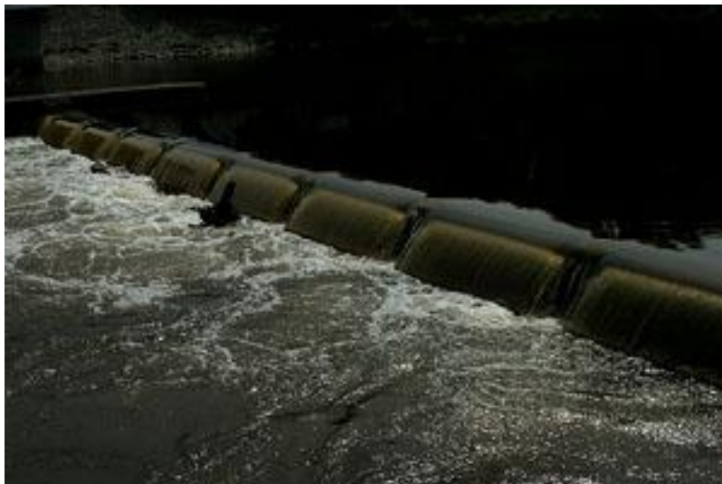
Stabilizační jez Strakonice
