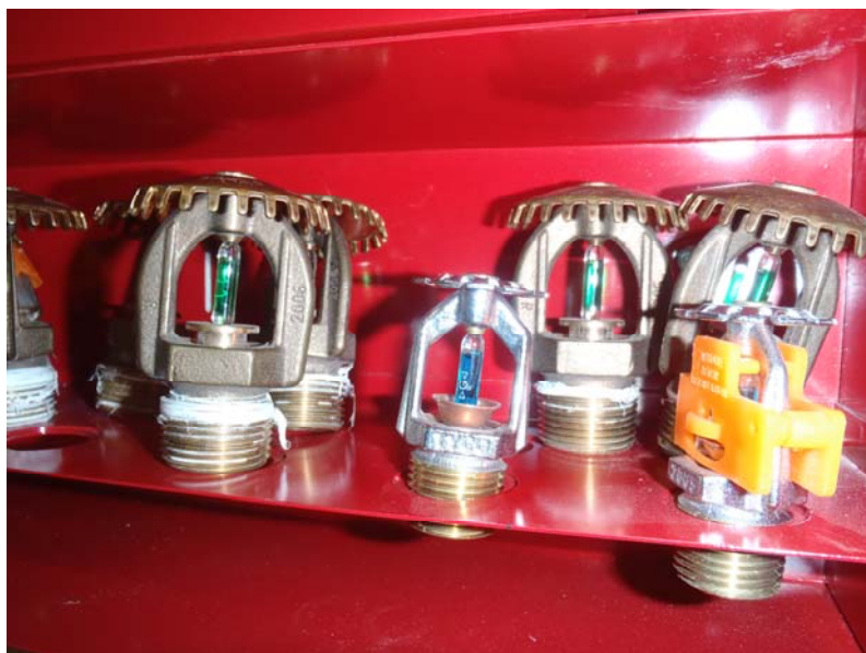
Obrázek 16: Ukázka použitých typů springlerových hlavíc
