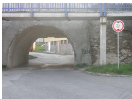
Obr. 2: Přístupová komunikace z ulice MUDr. K. Hradeckého
