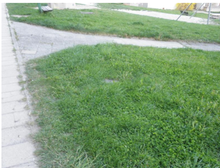
Obr. 16: Špatně viditelný podzemní požární hydrant
