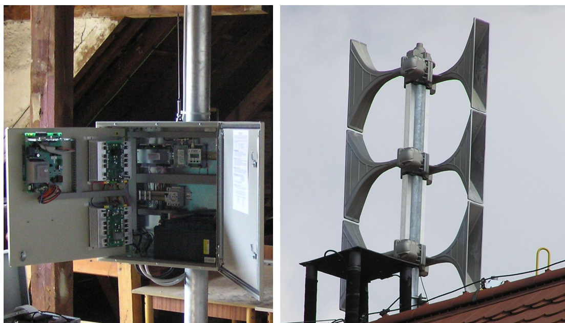
Obrázek č.12 - Řídicí jednotka a elektro-akustické měniče elektronické sirény ESP 750W
