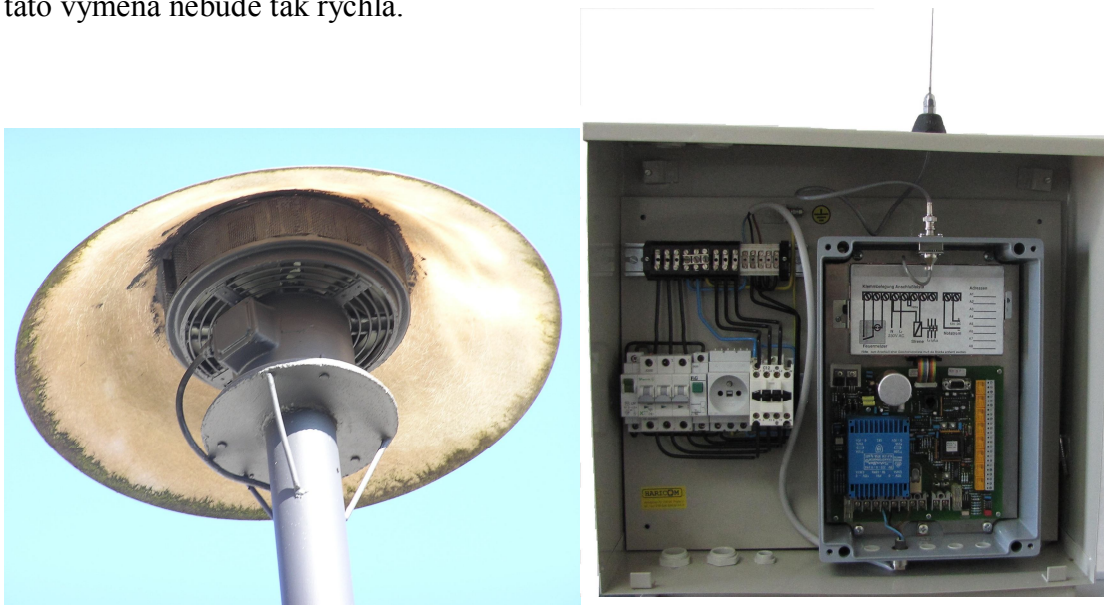
Obrázek č.11 - rotační siréna DS 977 s elektrickým rozvaděčem, ve kterém je umístěn přijímač dálkového ovládání DSE 200/8.
