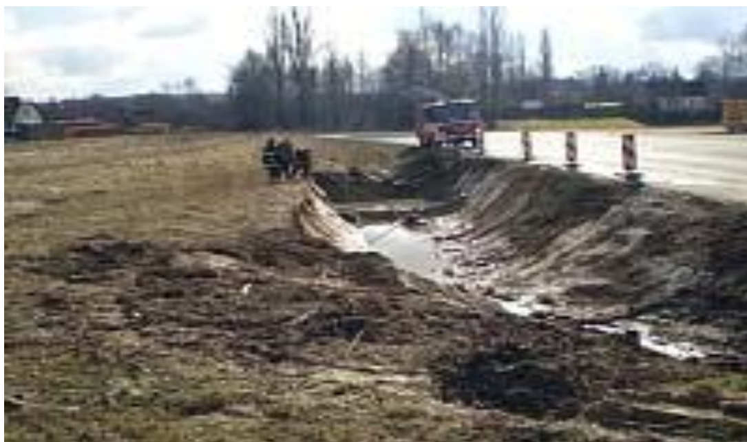
obr. č. 3: Pohled na výkop vzniklý vytěžením kontaminované zeminy
