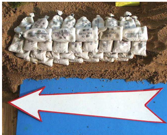
Obrázek č. 5: Překrytí koruny hráze řadou podélných pytlů (15)
