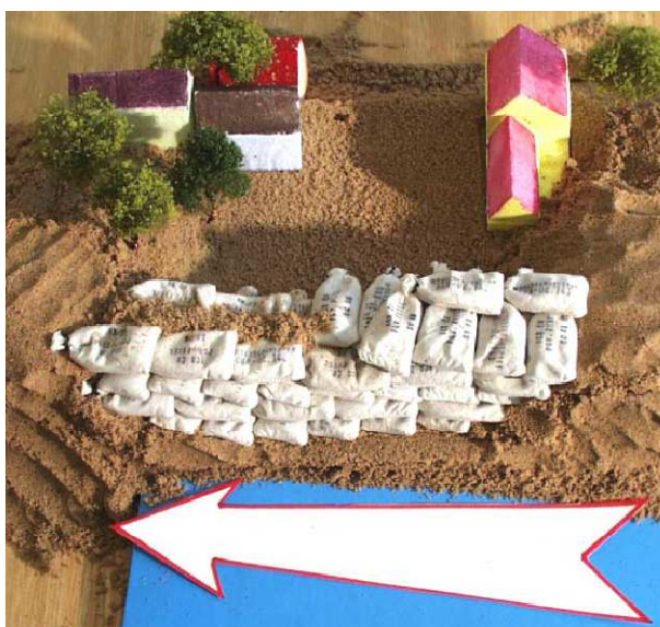
Obrázek č. 6: Kladení pytlů víceřadé kombinované (15)
