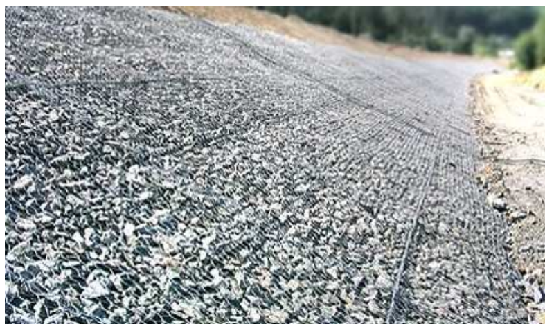
Obrázek č. 18 – Gabionové matrace (2)
