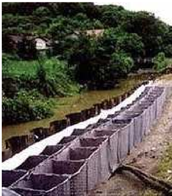
Obrázek č.19: Mobilní hráz z drátokošů – gabionů (9)
