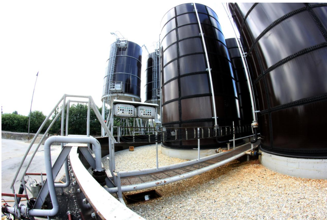
Obrázek 33 Havarijní vana o objemu jedné největší nádrže [zdroj: autor]
