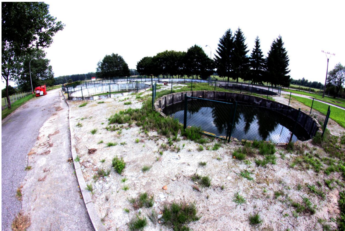
Obrázek 34 Bezodtokové záchytné jímky na dešťovou vodu apod. [zdroj: autor]
