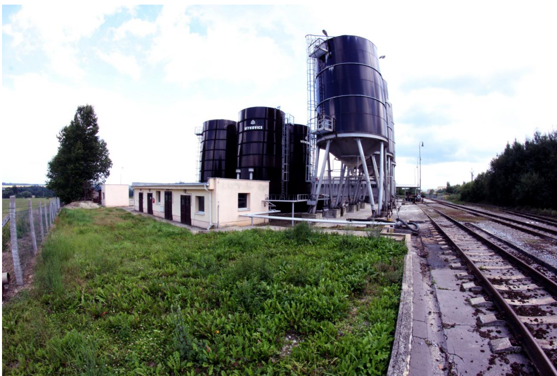
Obrázek 31 Čerpací stanice, za ní nádrže kapalných a vpravo mletých hnojiv [zdroj: autor]
