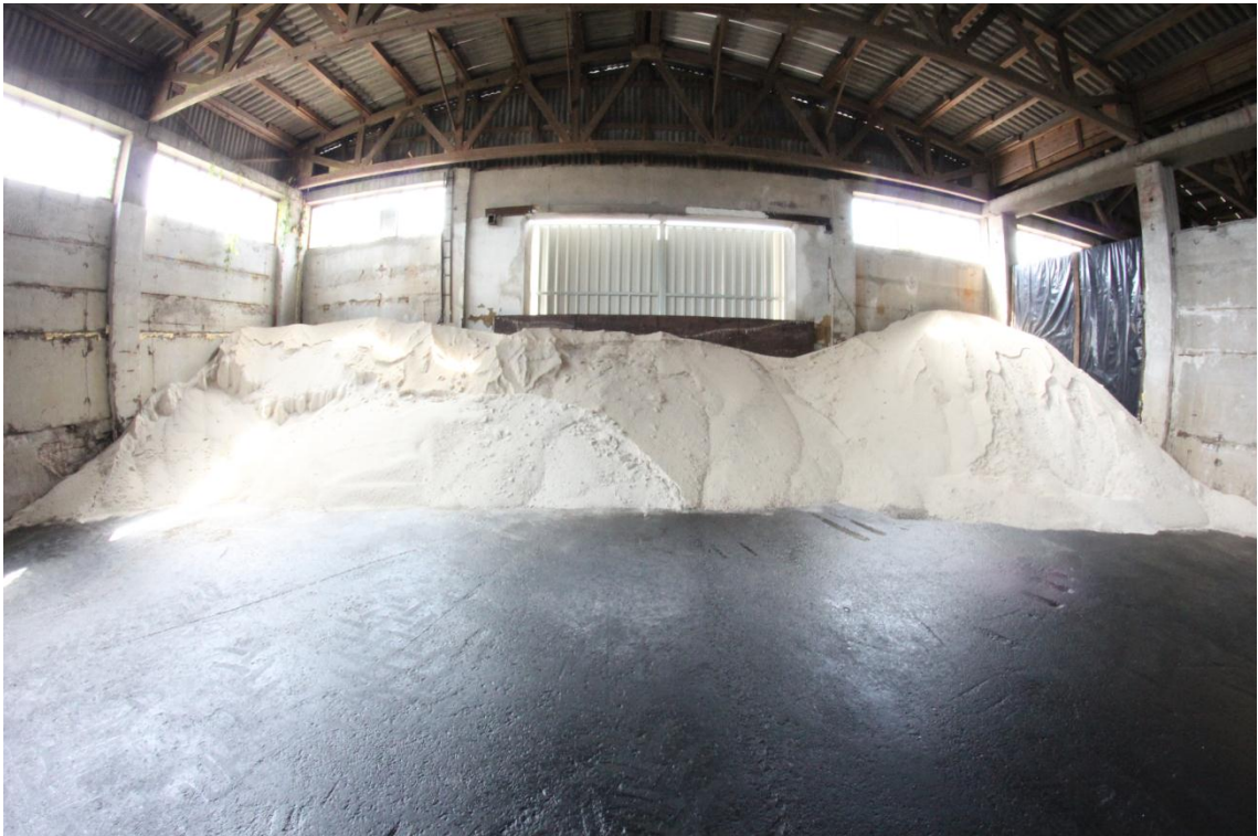
Obrázek 26 Pohled dovnitř jednoho z boxů skladu pevných hnojiv [zdroj: autor]
