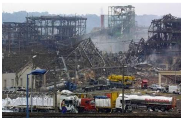
Obrázek 18 Toulouse 2001 – Zdemolované skladiště dusičnanu amonného [63]
