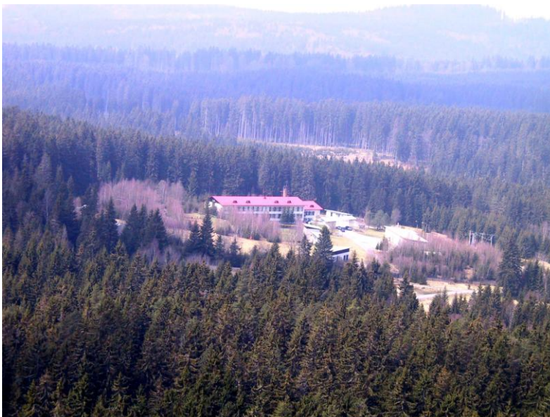
Objekt KŘP Jčk ve Stožci (celkový pohled)
