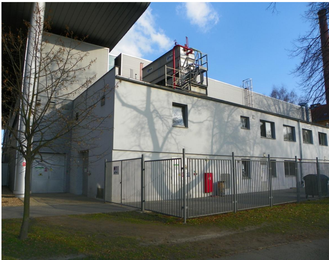
Obrázek č. 17: Strojovna zimního stadionu
