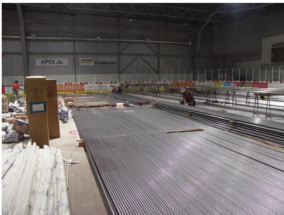
Obrázek č. 19: Pohled na rekonstruování chladicího zařízení v hale č. 2
