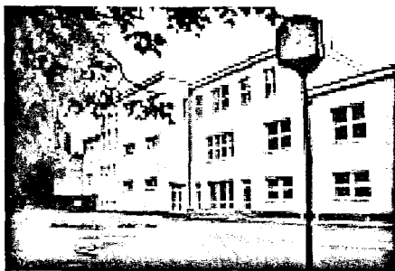
budova DPL Opařany
