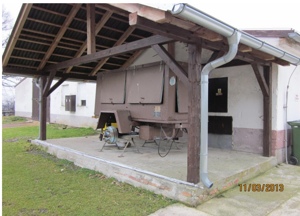
Obr. 3.3 Agregát – Nestanice (chov brojlerů a kuřic)
