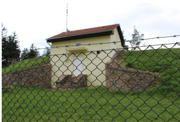
Obrázek 29: VDJ Vodňany, prvky pasivní ochrany, Zdroj: Vlastní výzkum
