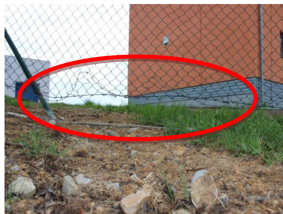
Obrázek 38: VDJ Hosín I, uvolněný plot, Zdroj: Vlastní výzkum
