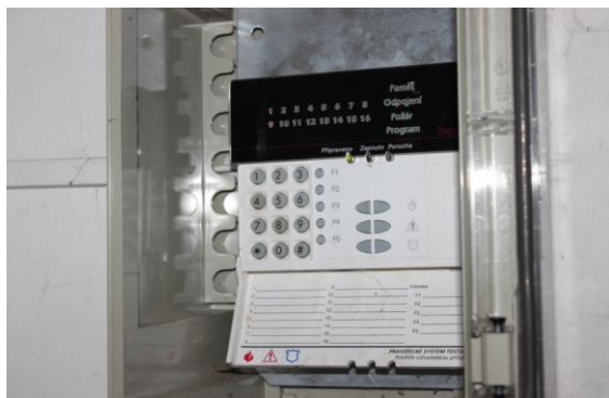
Obrázek 25: VDJ Amerika, kódovací zařízení, Zdroj: Vlastní výzkum
