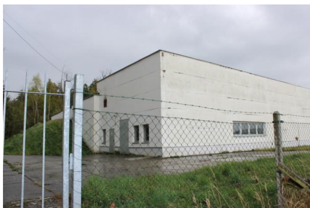
Obrázek 22: ČS Sudoměřice, prvky pasivní ochrany, Zdroj: Vlastní výzkum
