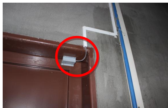
Obrázek 26: VDJ Amerika, dveřní spínač, Zdroj: Vlastní výzkum
