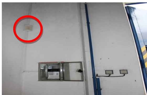
Obrázek 27: VDJ Amerika, pohybové čidlo, Zdroj: Vlastní výzkum
