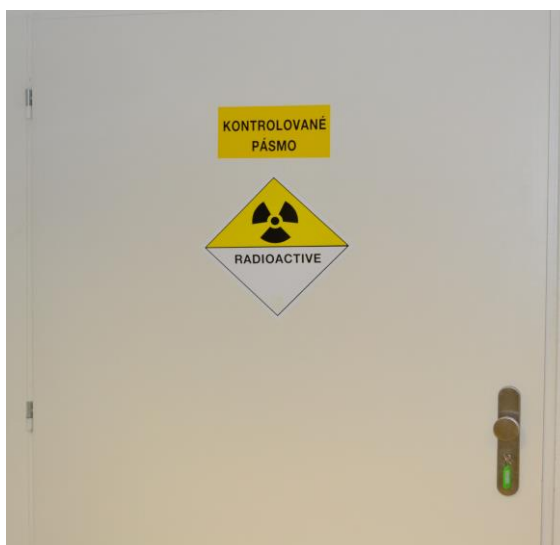
Obrázek 4: ochranné dveře s Pb vložkou
