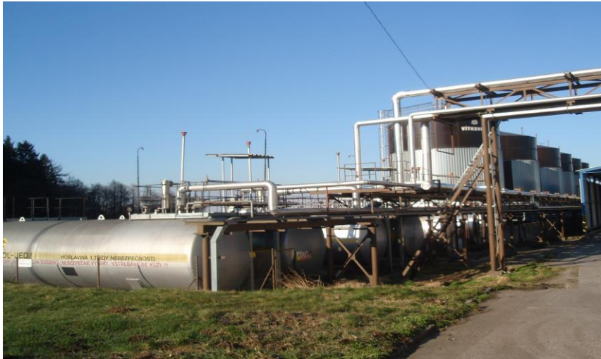
Obrázek 2. Skladovací nádrže v podniku Primgra, a.s (Zdroj: autor)
