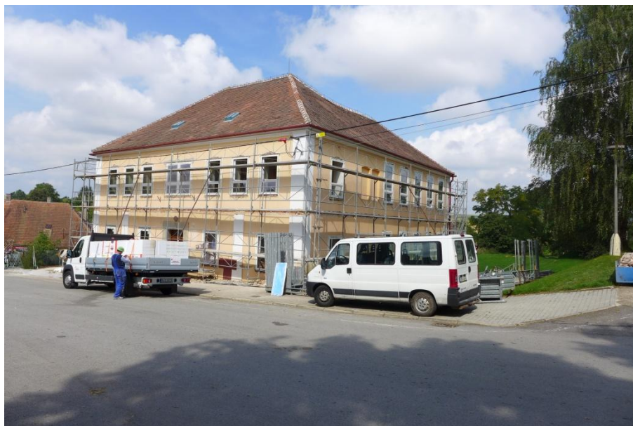
Obrázek č. 7 Základní škola Budkov – budova staré školy během rekonstrukce
