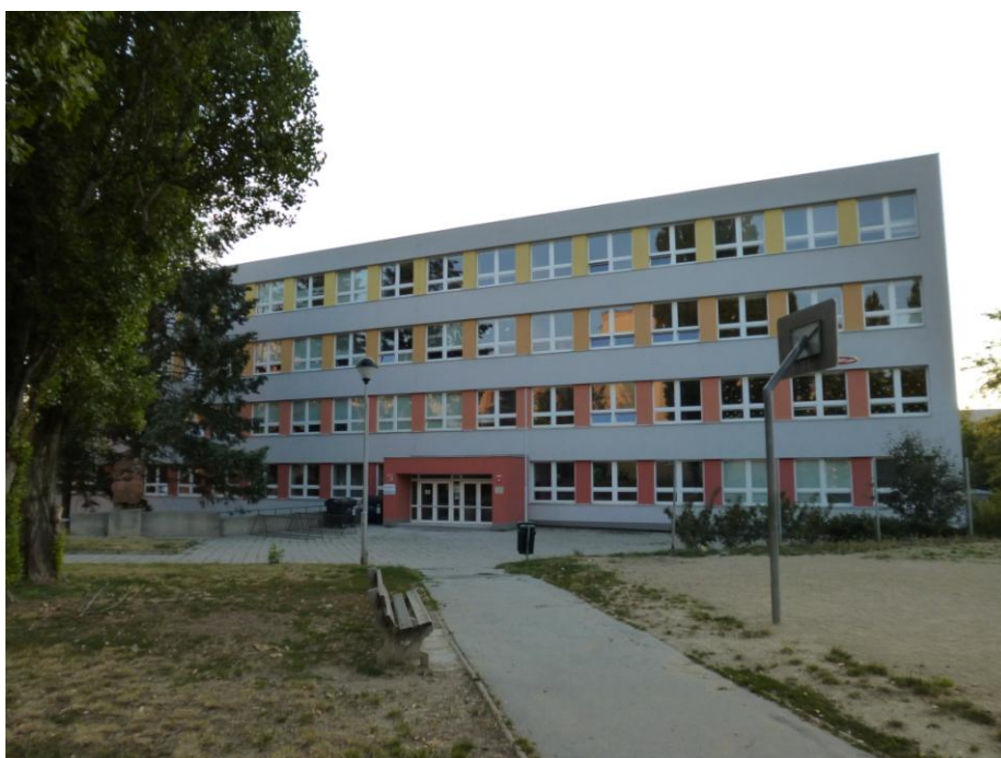
Obrázek č. 33 Budova ZŠ a MŠ Pražská Znojmo
