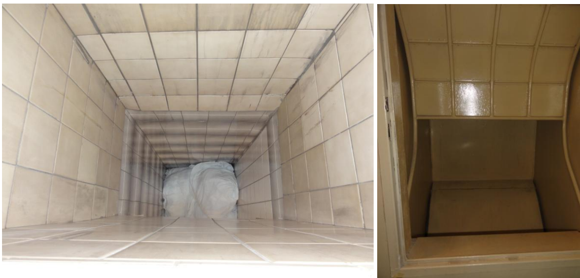
Obr. č. 81 Běžný shoz na prádlo a obr. č. 82 Lopatkový shoz na prádlo
