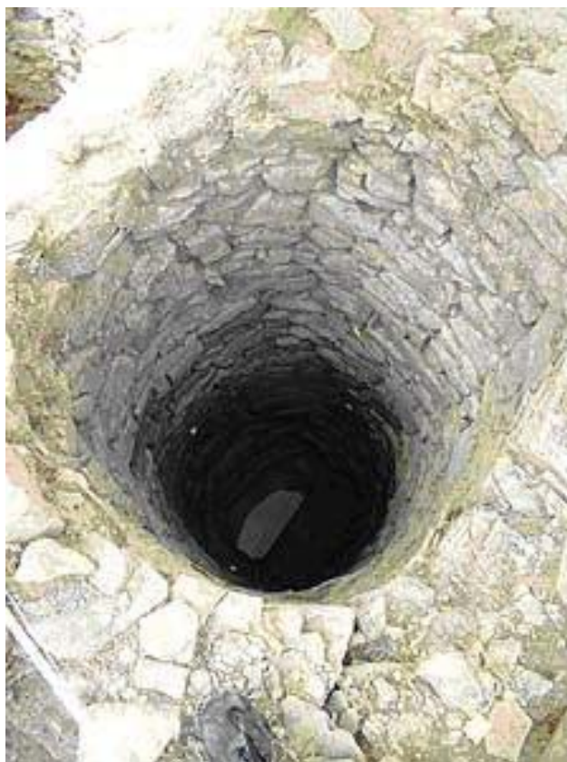
P 3: Kamenné roubení jedné z jímek.
