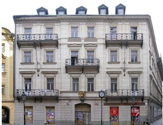
Obr. 2 Současný vzhled budovy (pohled z Celetné ul.)
