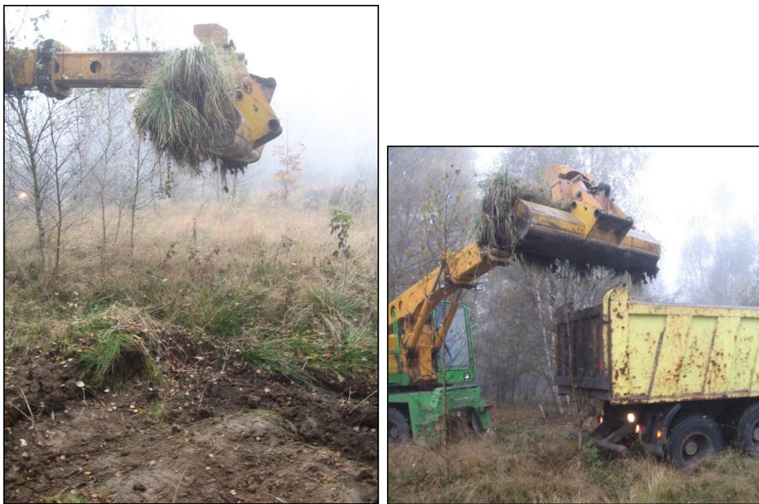
Obr. 5, 6: Odebírání drnů a svrchních vrstev půdy II., říjen 2007.
