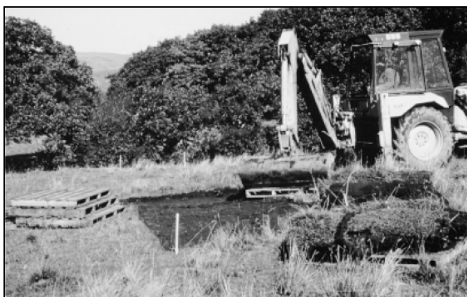
Obr. 2: Přenos kompaktních „bloků“ luční půdy spolu s drny (převzato z Good a kol., 1999)
