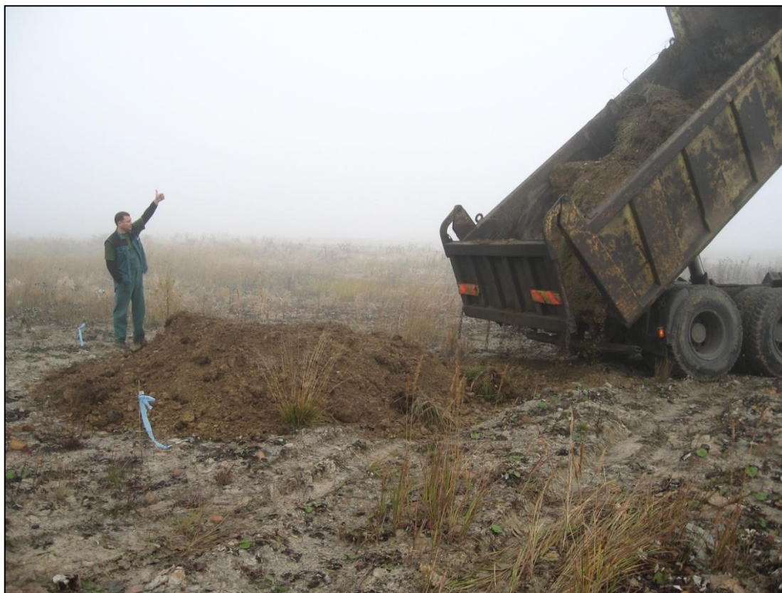
Obr. 7: Položení přenesených svrchních vrstev půdy spolu s drny II. z nákladního automobilu na nerektivovanou výsypku, říjen 2007.
