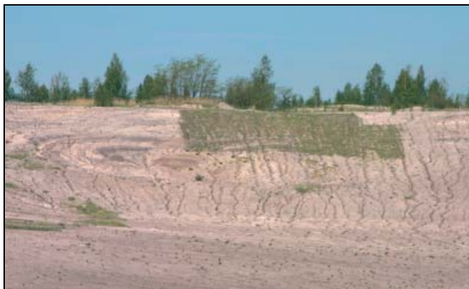
Obr. 3: Ochrana proti erozi aplikací pokoseného rostlinného materiálu na nerektivované výsypku Müheln (převzato z Tischew a kol., 2009).
