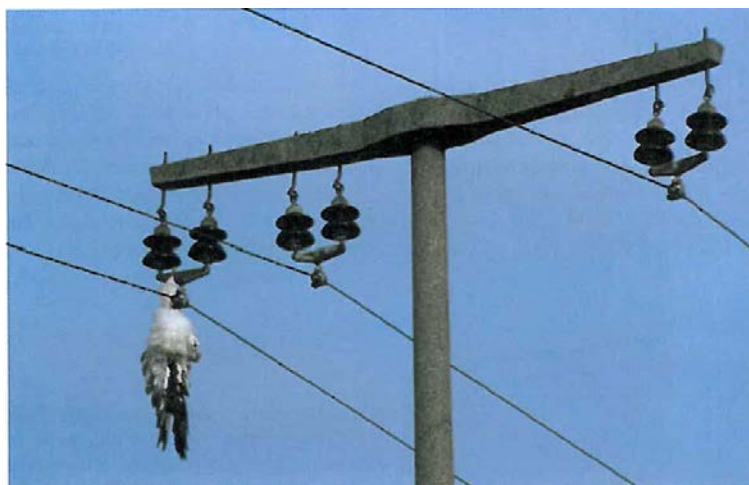
Obr. 2: Umrť ptáka při propojení uzemněné části konstrukce s vodičem (zdroj: APLIC 2006).
