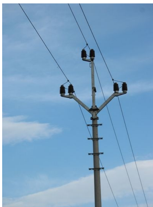
Obr. 4: Bezpečný typ konstrukce „pařát“ (zdroj: ČEZ)
