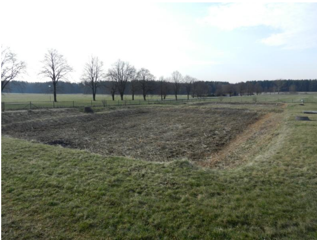
Obr. 11. Vegetační pole KČOV Slavošovice na jaře po vysekání rákosu z předchozího roku.
