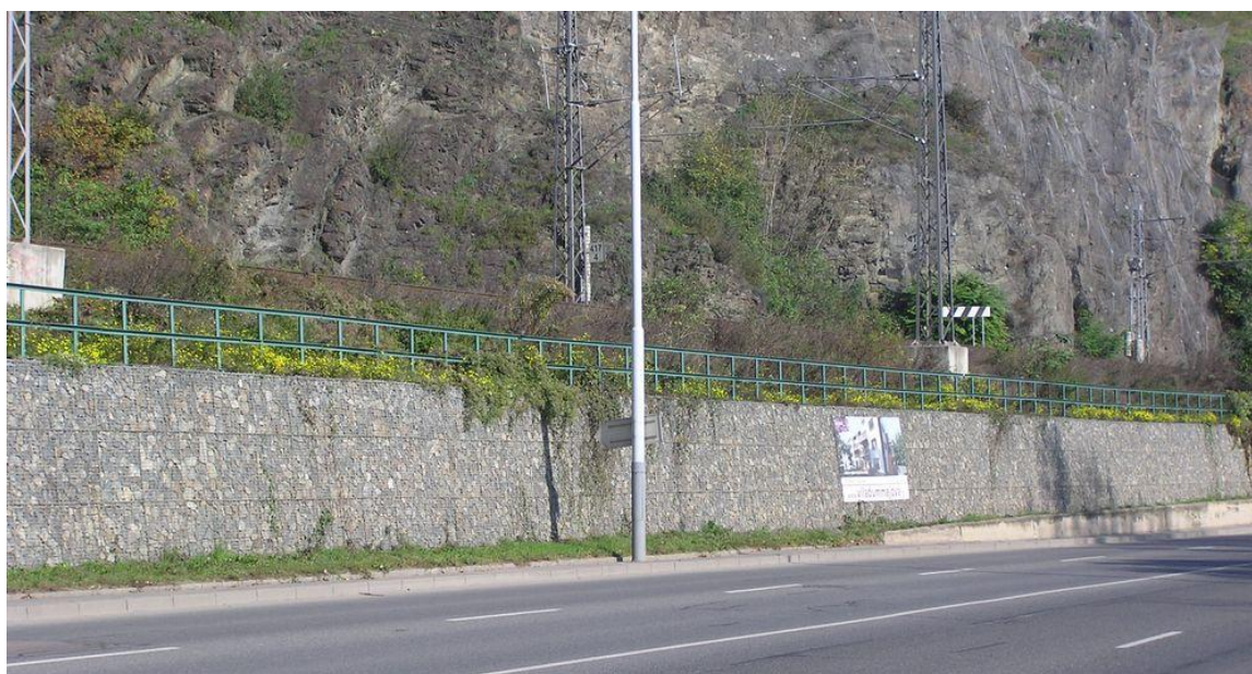
Foto 2 Směr Praha – Podbaba → Praha – Sedlec (říjen 2010)
