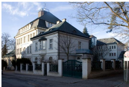
Moderní budova gymnázia V. Nováka
