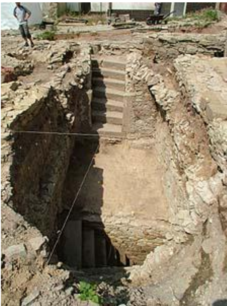
P 6: Schodiště vedoucí do sklepa.
