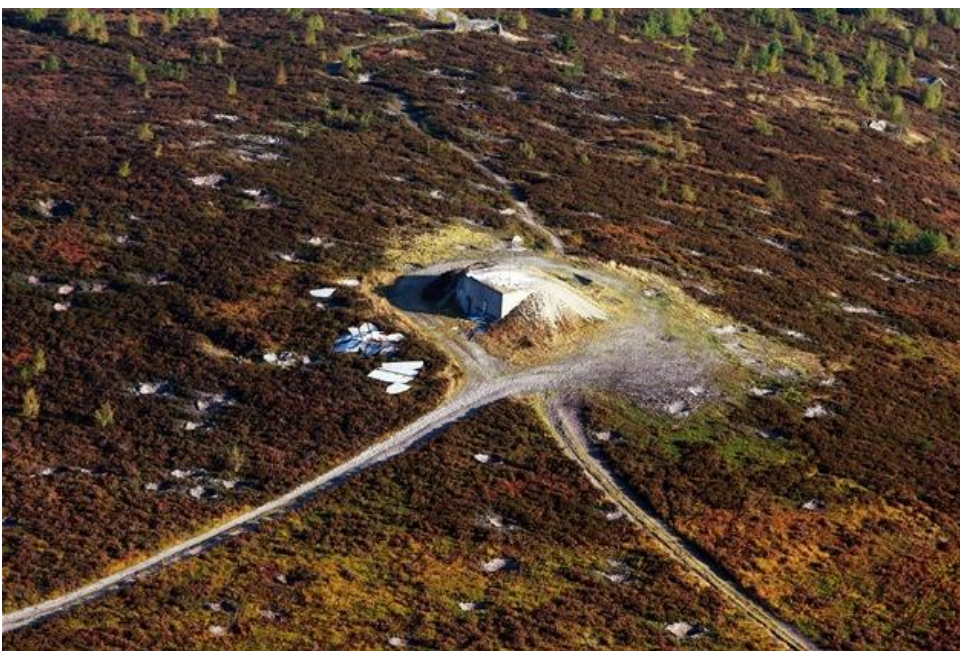
Obr. č. 10 Pohled na pčhotní srub na dopadové ploše Jordán, který je po několik desetiletí dělostřelecky ostřelován (Foto: Dan Materna).
