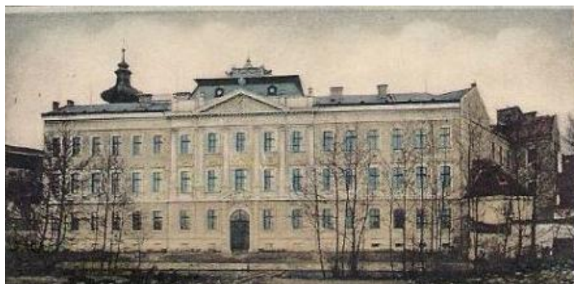
Obrázek 4 - Historická budova gymnázia v České ulici
