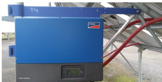
Obrázek 9: Průmyslový měnič SUNNY TRIPOWER 15000, max. účinnost 98 %.
