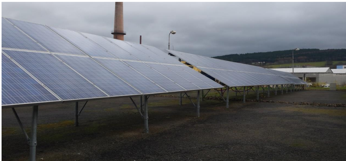
Obrázek 4: Panely typu YL230P-29b polykrystal, lokace Sunny stream Prachatice.
