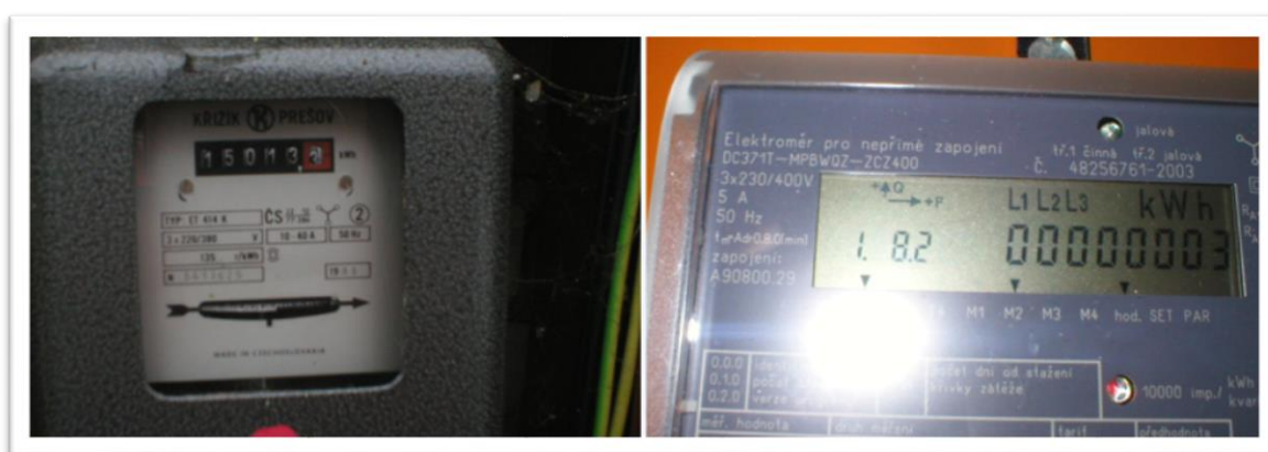
Obrázek 9 – ukázka vizuálních typů podporovaných elektroměrů
