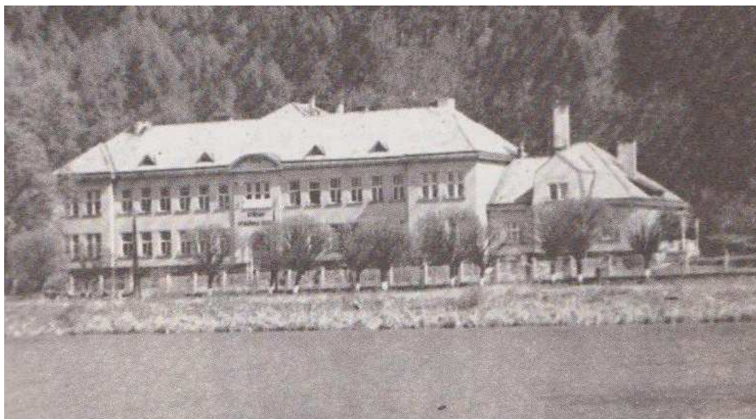
Obr. 14 Střední rybářská škola ve Vodňanech.
