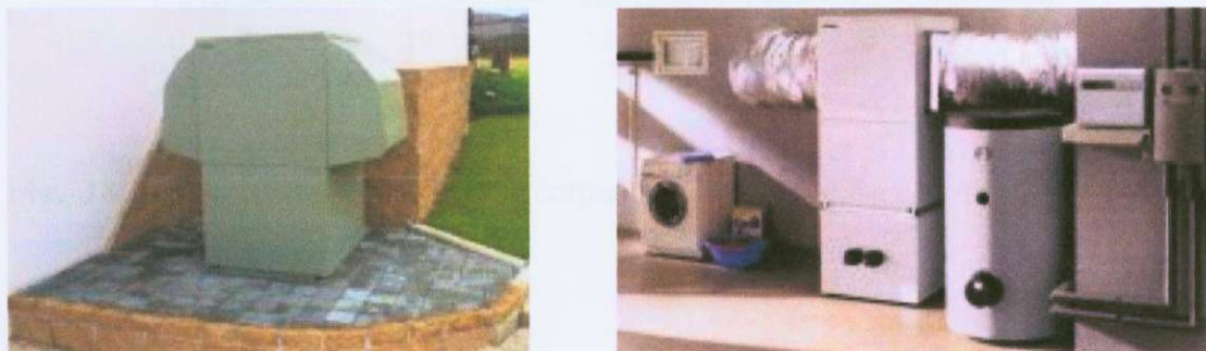
obr 17: kompresorové tepelné čerpadlo, které získává zdroj tepla z podloží – vrtu.
