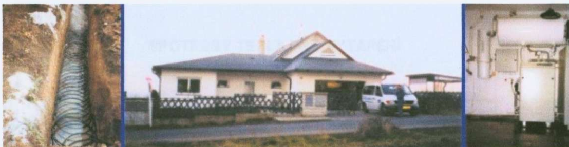
obr. 16: zemní kolektor pro tepelné čerpadlo, vytápěný objekt a vnitřní část tepelného čerpadla
