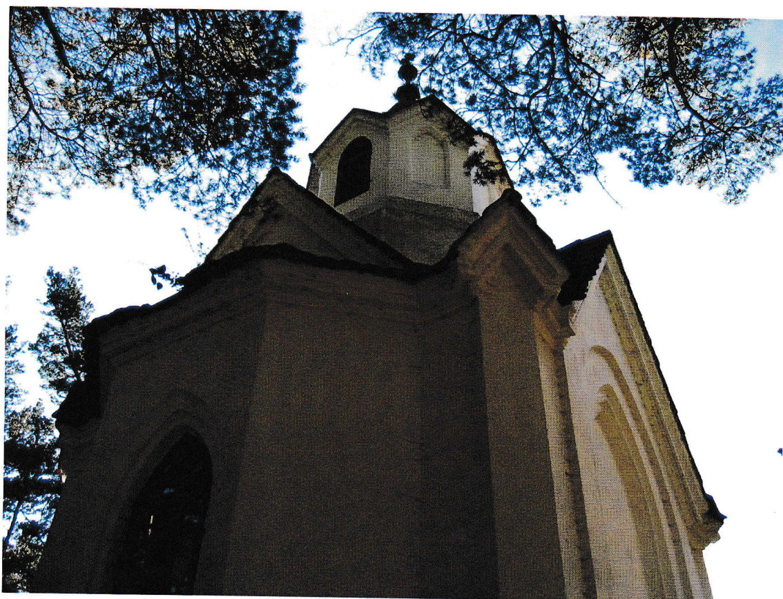
Pohled na zvonici kaple.
