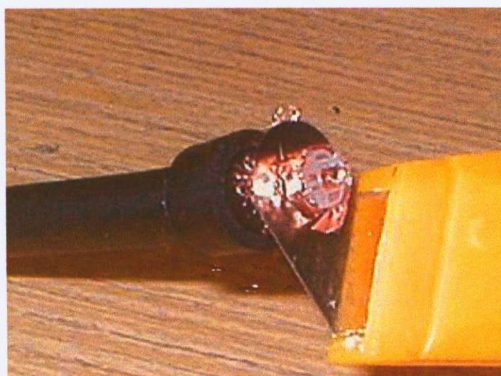
Obr. 26: seříznutí izolantu
