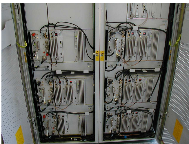
Obrázek 27 – Basic rack + extension cabinet
