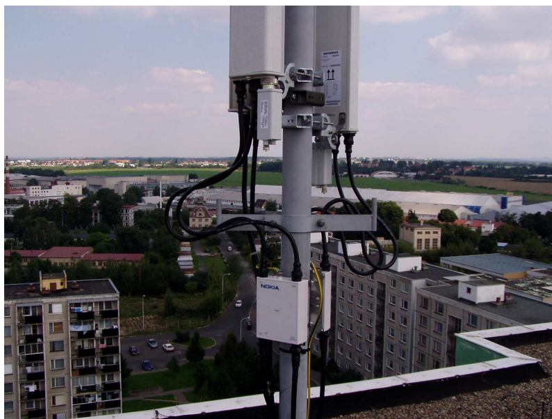
Obrázek 23 – UMTS antény s předzesilovačem a motorem
