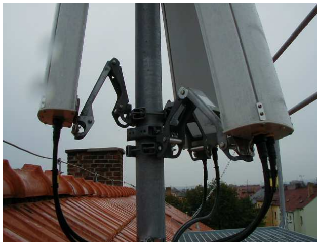
Obrázek 22 – Crossdiverzitní antény GSM
