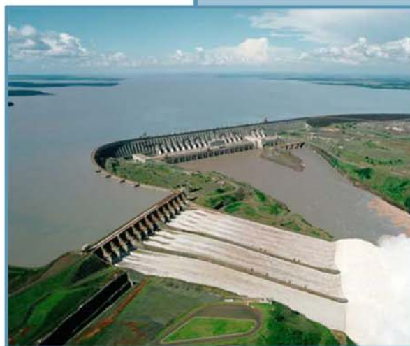
Obr. 60. Brazílie s Paraguayí vybudovaly jednu z největších vodních elektráren světa - Itaipú. Jedna taková elektrárna vyrobí tolik energie, že by pokryla spotřebu celé České republiky.
