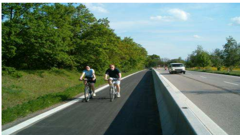
Obrázek 10. Cyklostezka Č.Budějovice – Hluboká nad Vltavou kolem hlavní silnice.
