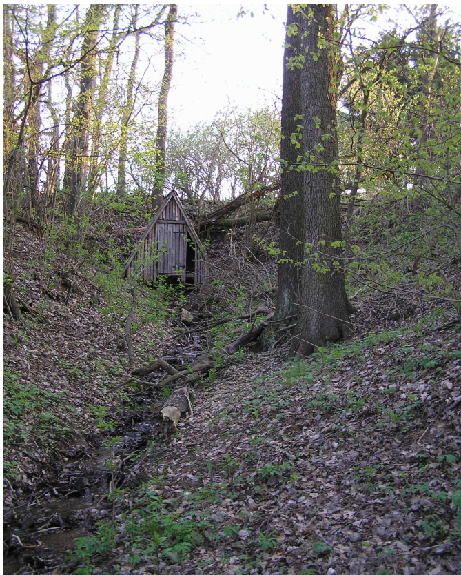
Pohled na ústí staré dědičné štoly
