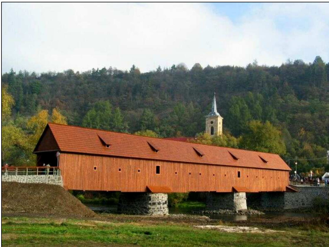
Radošov, krytý dřevěný most z roku 2003
