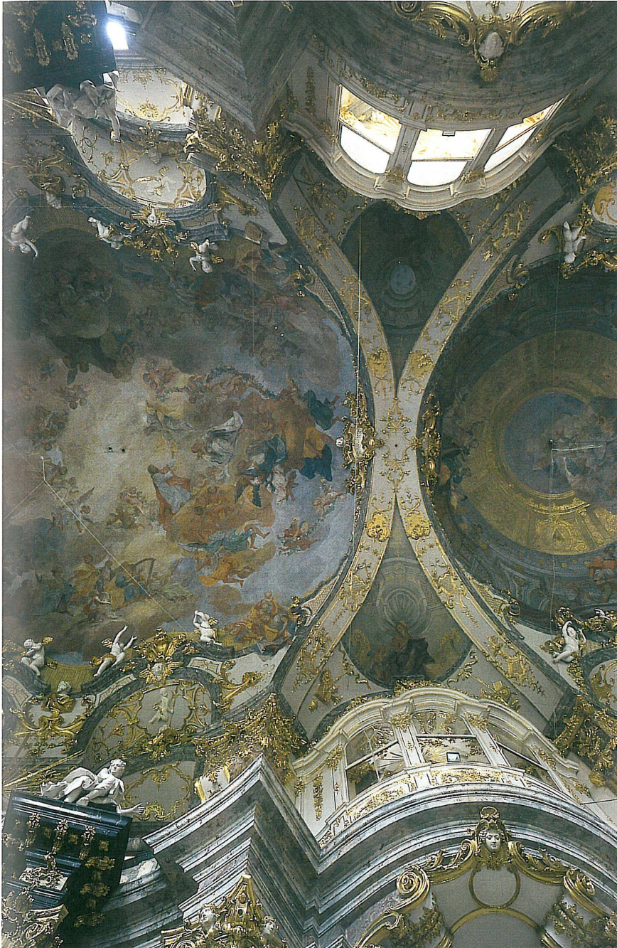
◀ 66 Hofkirche der Residenz zu Würzburg. Blick in das Gewölbe mit den mehrdimensional kurvierten Gurten an der Berührungsstelle von zwei Hauptovalen.
