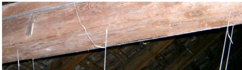
Obr. č. 4.2.2 Uchycení závěsu na trámu
