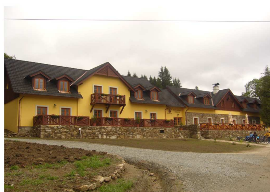
Opravená hájovna na Žofíně
