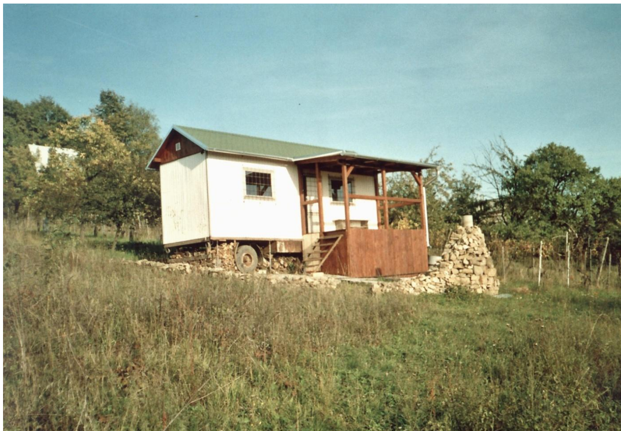
Obr. 26. Architektonicky specifická chata – maringotka CHAAS m v chatové osadě ZL7.Y.CHS.6. Strážnice - Mlýnky – Svárové.
