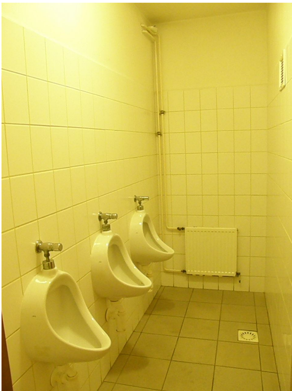
Prostor veřejných toalet před instalací
