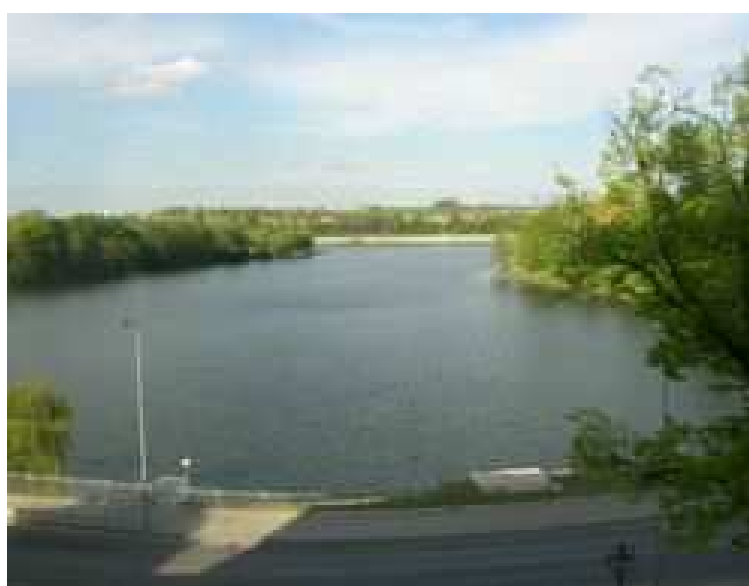
Obr. č. 13: Pohled na údolní nádrž Jordán od hráze
