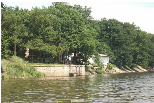
Výpust hráze rybníka Rožmberka
