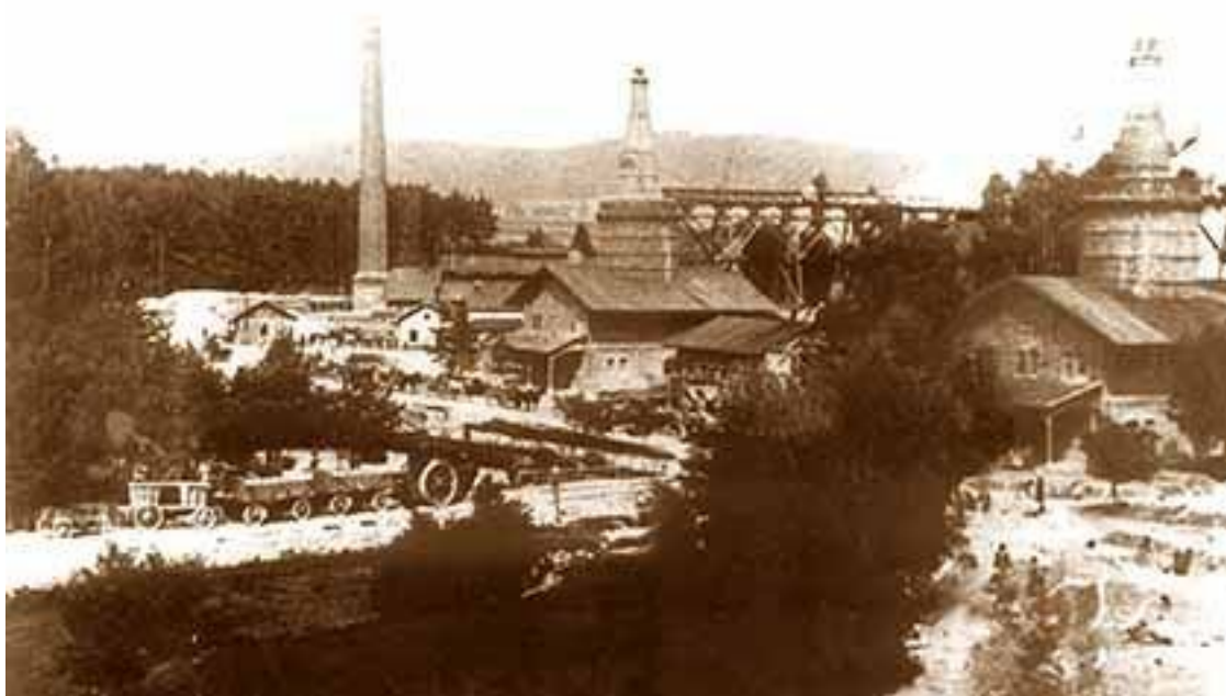
Obr. č. 21: Vápenky v lomu Pacova hora – pece na pálení vápna a další technické objekty z počátku 20. století – v současnosti již žádný z nich neexistuje (převzato: http://www.volny.cz/jeskynechynov/ )
