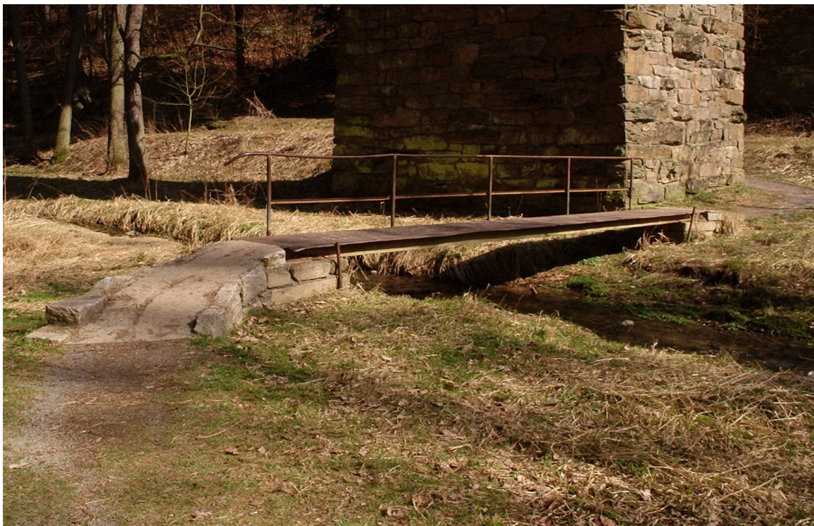
Obr. č. 3: Lávka u viaduktu (foto autor 2008)
