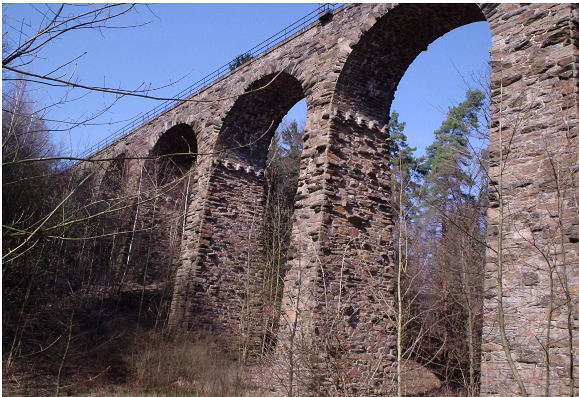
Obr. č. 1: Viadukt (foto autor 2008)
