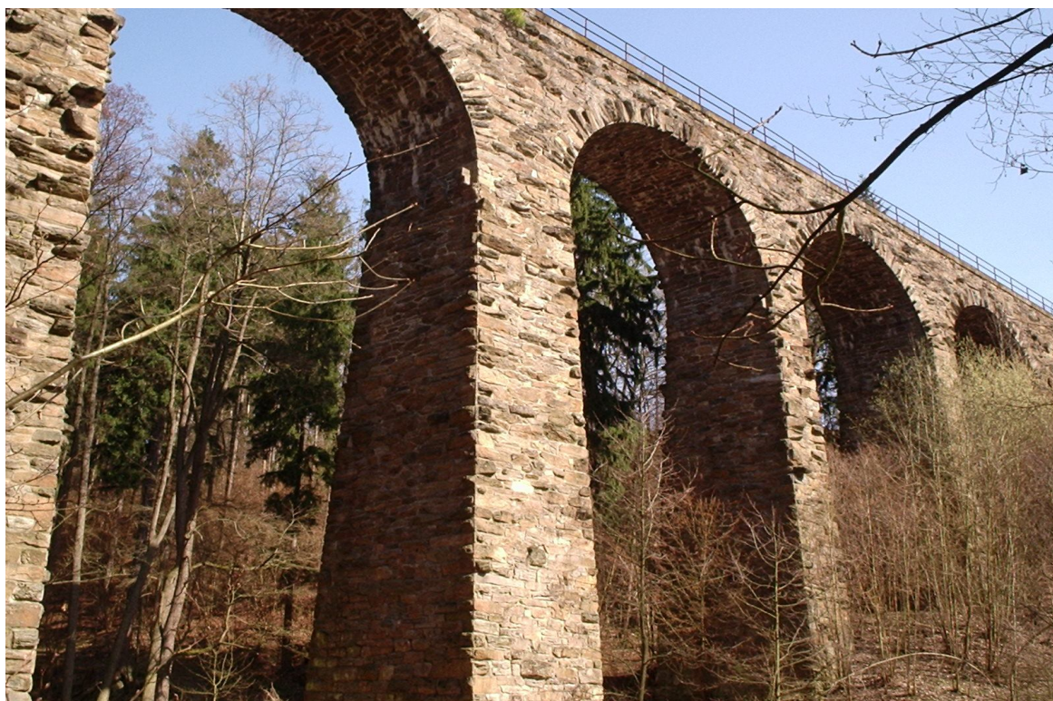
Obr. č. 2: Viadukt (foto autor 2008)
